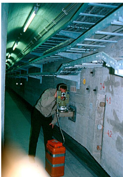
Figura 6 – Barragem do Alto Lindoso – poligonal de precisão – medição de ângulos (Kern E2)
