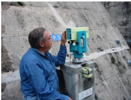
Figura 3 – Barragem de Pracana – poligonal no paramento de jusante, materializada por pilares de centragem forçada (cota 83)
