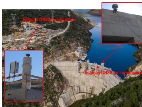
Figura 4 – Localização das estações GNSS na barragem de Foz Tua: a estação objeto, no coroamento da barragem, e a estação de referência, na margem direita
