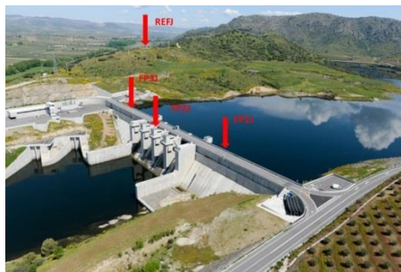
Figura 3 – Localização das estações GNSS na barragem do Feiticeiro: FP1J, FP2J e FP3J, no coroamento da barragem, e REFJ, como estação de referência, na margem direita
