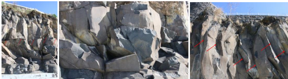
Figura 2 – Estado de fraturação do maciço rochoso
